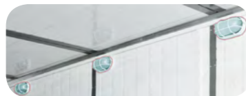
Система рабочего, аварийного и ремонтного освещения 220 и 24 В
